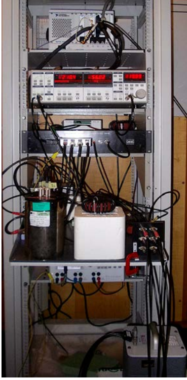
Fig. 3: Picture of the generating bridge developed at the Istituto Nazionale di Ricerca Metrologica.
